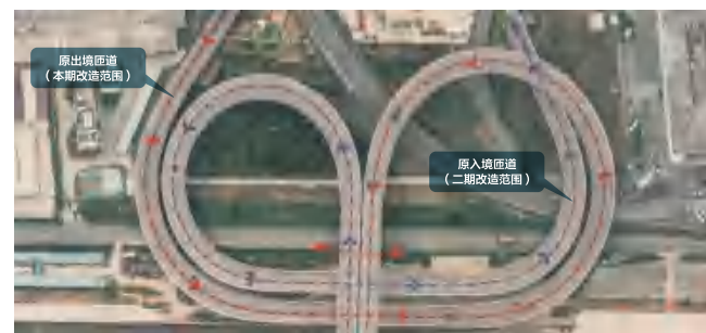
图 1 2018 年 1 月莲花大桥改造前航拍图
