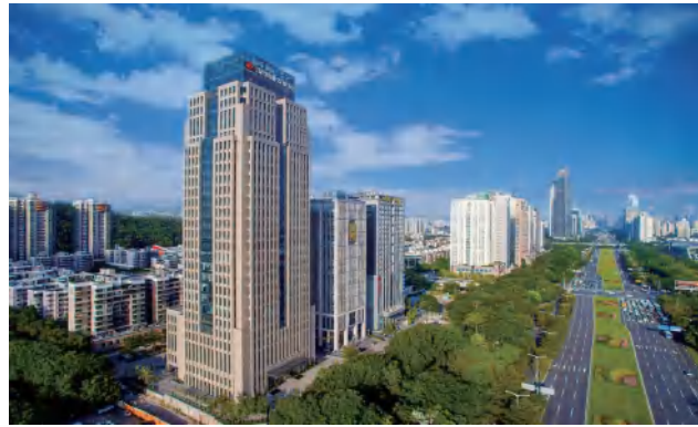
建安大厦工程获得2018—2019年度中国建设工程鲁班奖。
