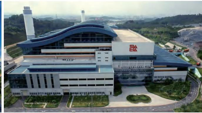
老虎坑垃圾焚烧发电厂项目荣获2013—2014年度国家优质工程金质奖。
