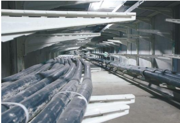
沈阳市地下综合管廊项目
