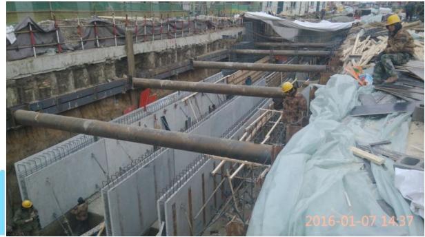
哈尔滨市地下综合管廊建设工程
